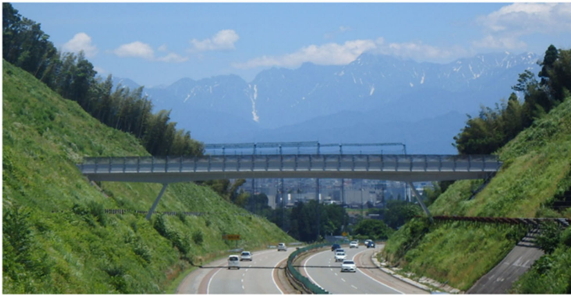
(杉谷第2跨道橋)
