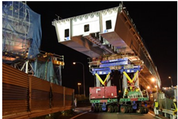
(多軸台車で橋桁を運搬する事例)
