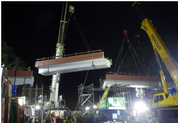
(クレーンによる吊り上げの事例)
