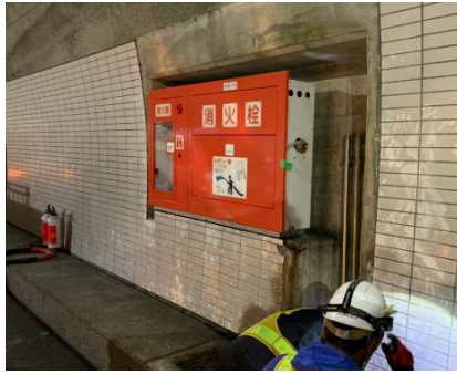
トンネル非常用設備の更新
