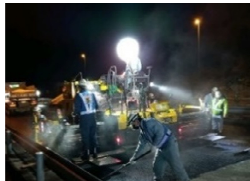
舗装補修工事
