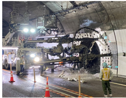
避難連絡坑拡幅工事のイメージ
