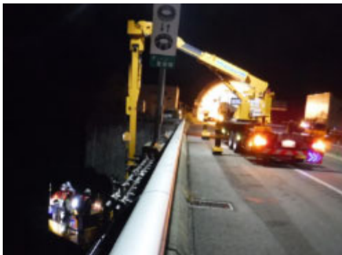
特殊点検車両による橋梁点検
