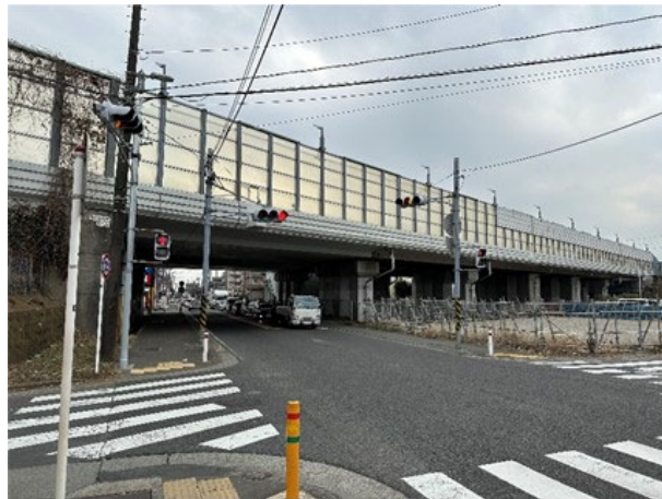
大和高架橋の橋梁全景
