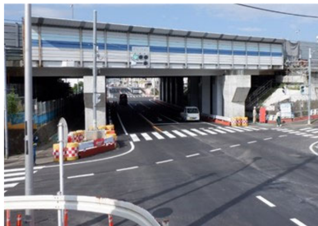
大東橋の橋梁全景
