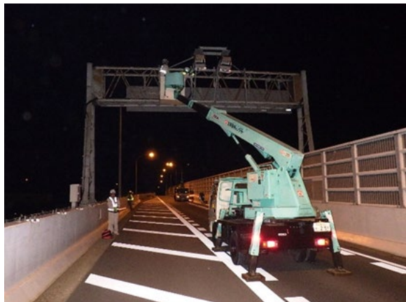
ETC 無線通信専用アンテナ 設置工事
