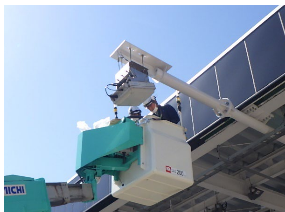
ETC 無線通信専用アンテナ 設置工事
