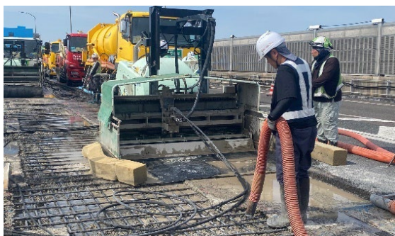
老朽化した床版の補修状況
