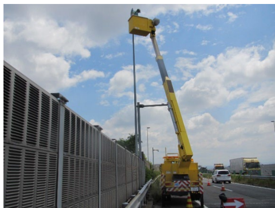
道路照明設備の点検
