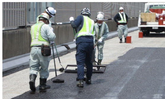
床版防水工の施工状況
