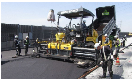
新たな舗装の施工状況
