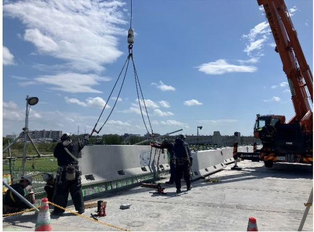
工場製の壁高欄の設置
