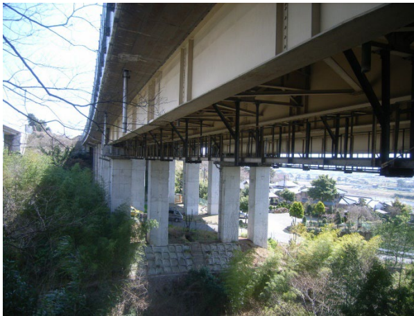
＜大沢橋の橋梁全景＞
