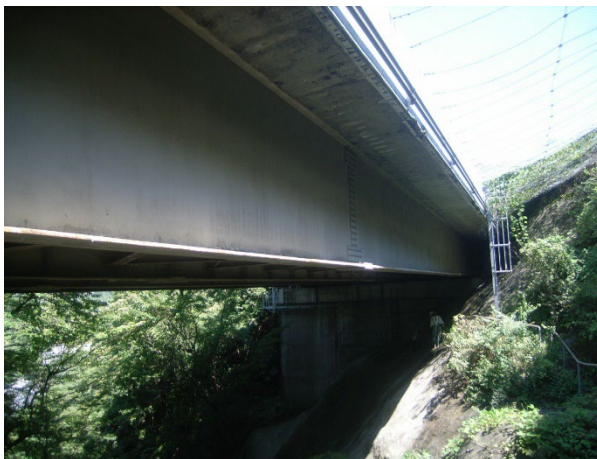
＜柏木第一橋の橋梁全景＞
