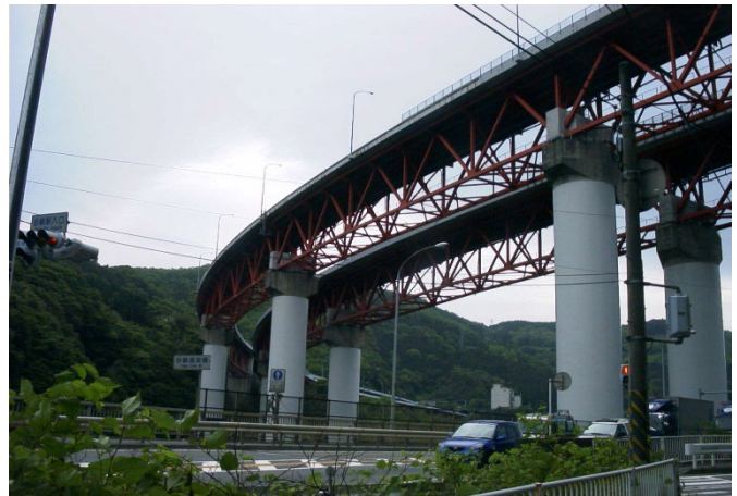
＜酒匂川橋の橋梁全景＞
