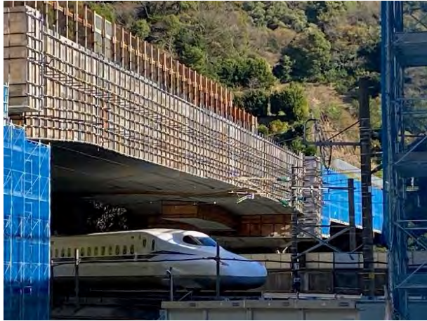
＜清見寺橋の橋梁全景＞
