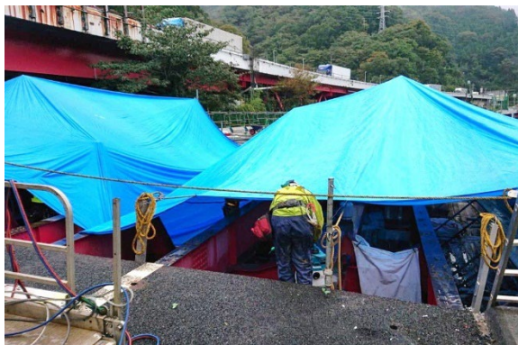
【雨天対策設備の設置状況】
