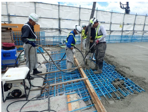
【現場打ち床版の施工状況】
