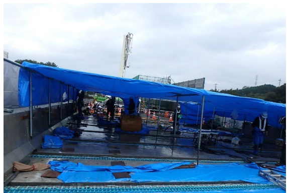
【雨天対策設備の設置状況】
