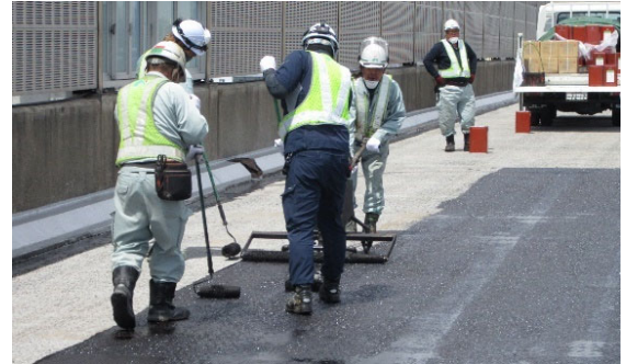
床版防水工の施工状況
