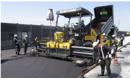
新たな舗装の施工状況
