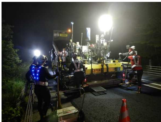
舗装工事(イメージ)
