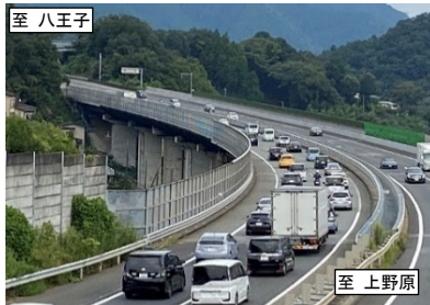
<小仏 TN 付近（上り線）の渋滞状況>
