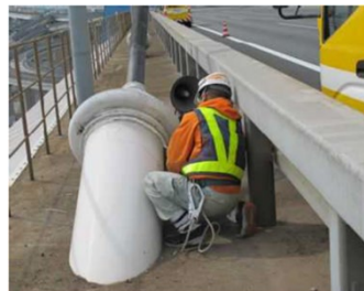
参考写真 2 ケーブル定着部
