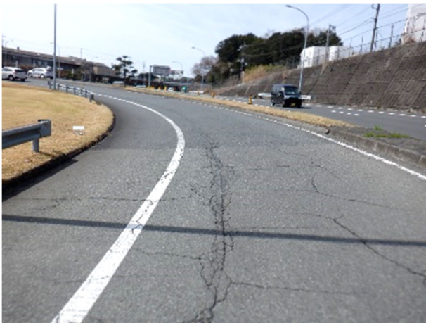
【沼津 IC (上り線) ランプ損傷状況】
