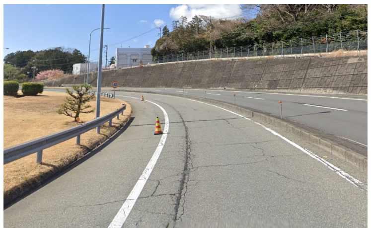
【沼津 IC (上り線) ランプ損傷状況】
