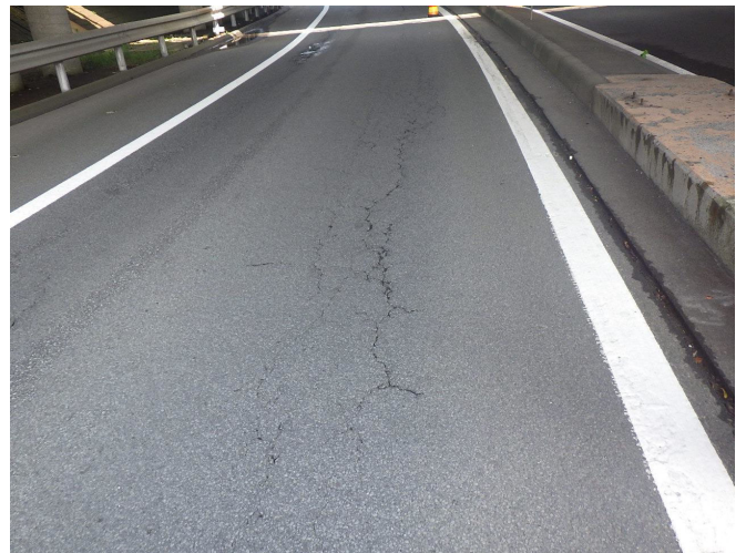
【御殿場 IC (下り線) ランプ損傷状況】
