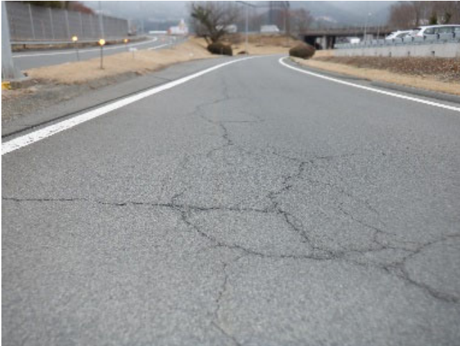
【御殿場 IC (下り線) ランプ損傷状況】
