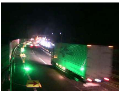
視線誘導の設置例
