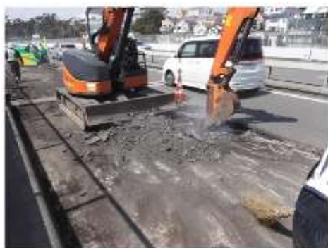
舗装撤去状況
