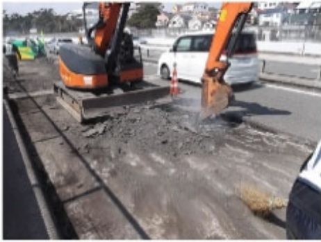
舗装撤去状況
