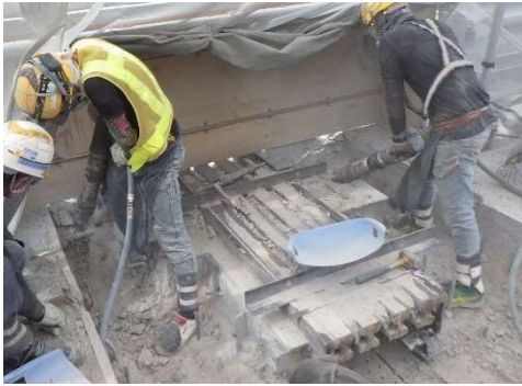
I. 既存の橋梁伸縮装置を撤去
