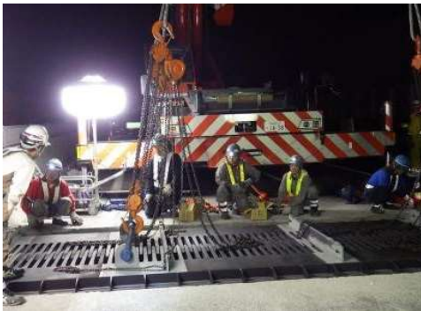
III. 新しい橋梁伸縮装置を設置
