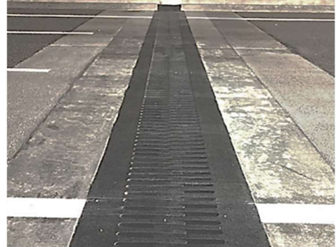
IV. 工事完了
