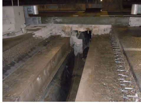
II. 橋梁伸縮装置の撤去後の状況
