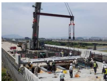
【床版取替工事の様子】
