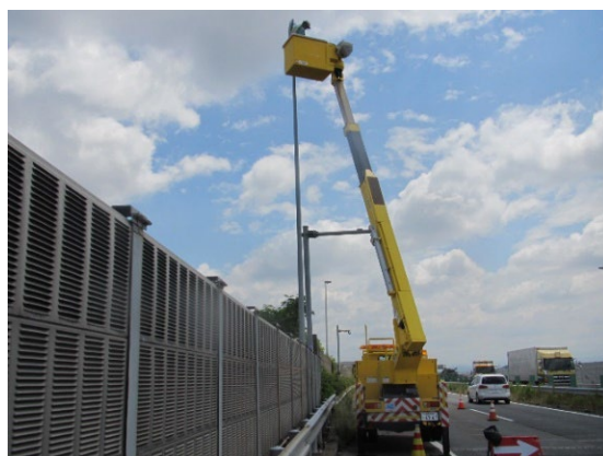
道路照明設備の点検
