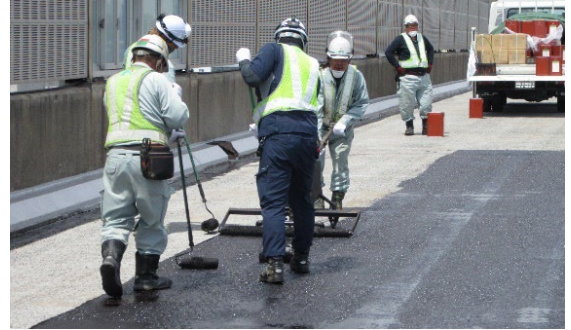
床版防水工の施工状況
