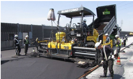
新たな舗装の施工状況
