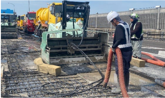
老朽化した床版の補修状況
