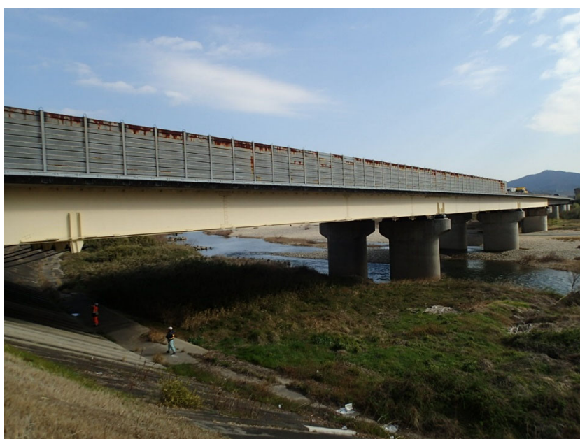
豊川橋の橋梁全景
