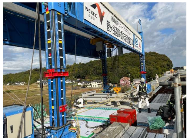
新しい床版の架設
