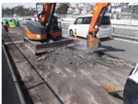
舗装撤去状況
