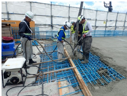
現場打ち床版の施工
