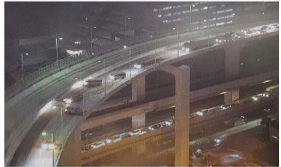
車両の滞留 ＜首都高速道路 台場線＞
