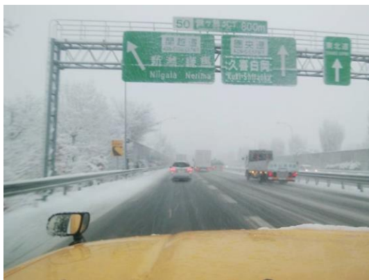
積雪状況 (圏央道 鶴ヶ島JCT付近)
