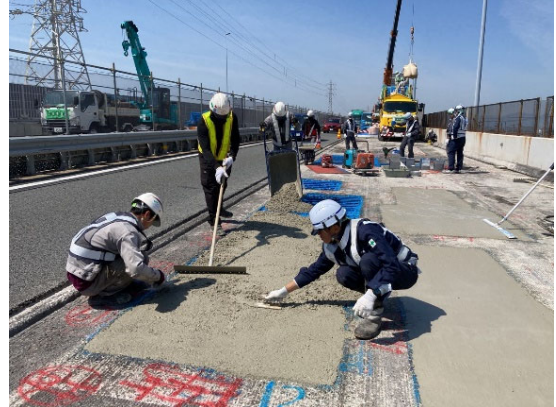
床版の補修状況
