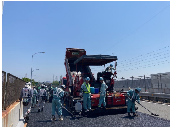
舗装の補修状況
