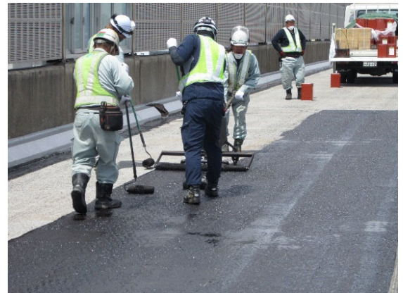
床版防水工の施工状況
