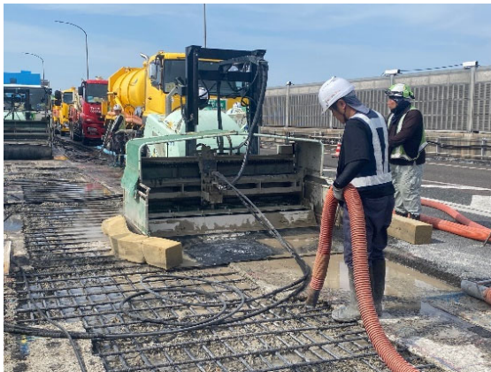
老朽化した床版の補修状況
