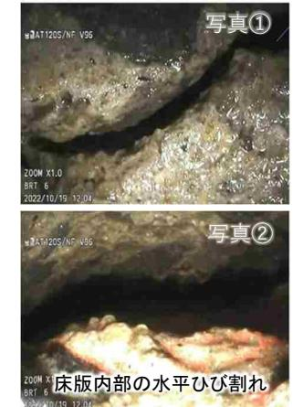
(小径削孔調査による水平ひび割れの確認)
