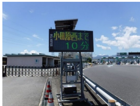
【迂回ルートへの分岐部手前の専用の道路交通情報板の所要時間表示イメージ（過年度設置状況）】
