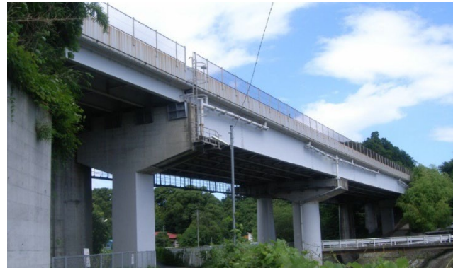
中村川橋の橋梁全景
