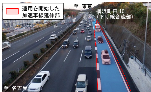
<横浜町田IC（下り線）加速車線延伸（2022.11）>
