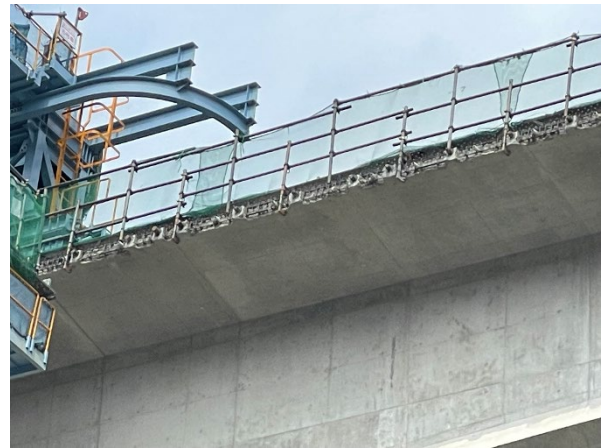
作業後の既存床版
