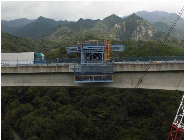
作業前の既存床版
