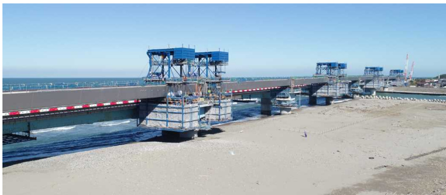
老朽化した床版・橋げたの撤去状況(山側から撮影)
