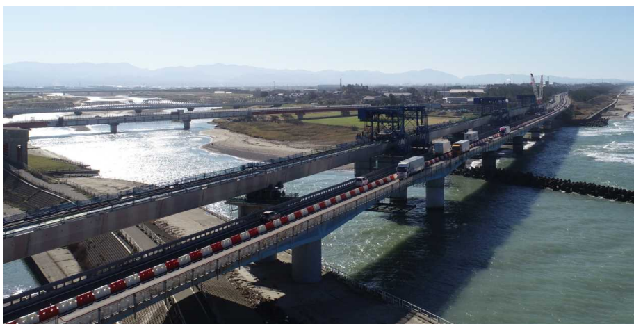
老朽化した床版・橋げたの撤去状況(海側から撮影)
