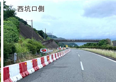
昼夜連続車線規制の状況
