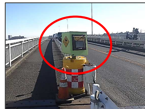
国道1号馬入橋(神奈川県平塚市)
