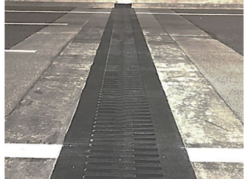
IV. 工事完了
