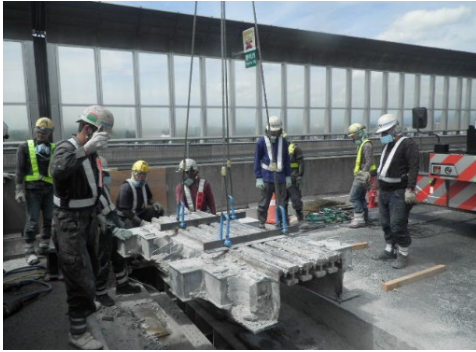
I. 既存の橋梁伸縮装置を撤去
