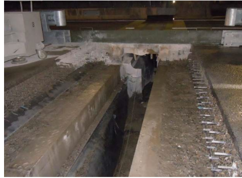
II. 橋梁伸縮装置の撤去後の状況
