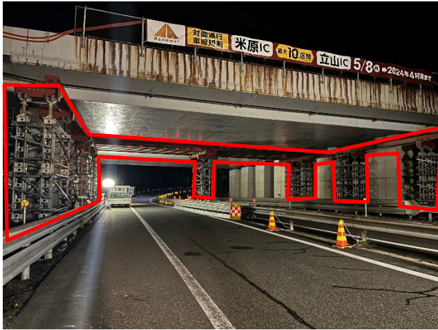
仮設構造物の設置状況
