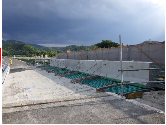
【参考】北陸道リニューアル工事における 本線橋の補修状況
