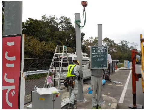
ETC 設備の改造工事
