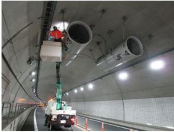
<トンネル点検>
