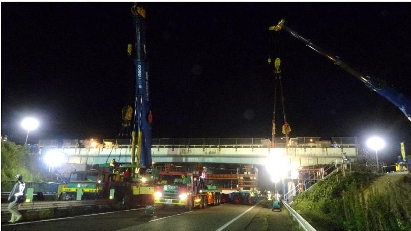
(大型クレーンによる跨道橋の撤去作業(イメージ))
