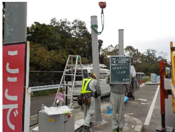
ETC 設備の改造工事
