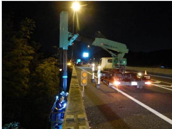
橋梁点検の状況
