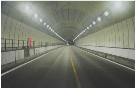
更新前の黄色路面標示（イメージ）
