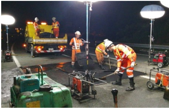
舗装補修工事
