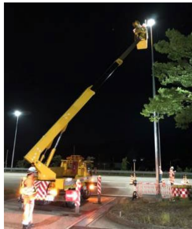
高所作業車を用いた道路照明設備点検
