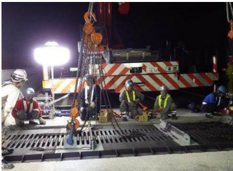
III. 新しい橋梁伸縮装置の設置
