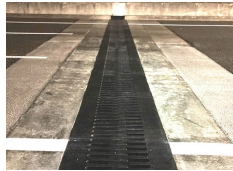
IV. 工事完了
