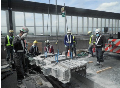
I. 既存の橋梁伸縮装置を撤去
