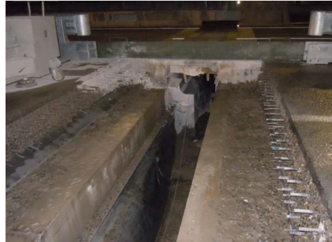
II. 橋梁伸縮装置の撤去後の状況
