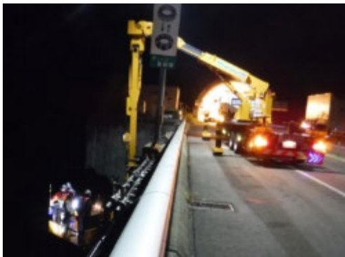
特殊点検車両による橋梁点検
