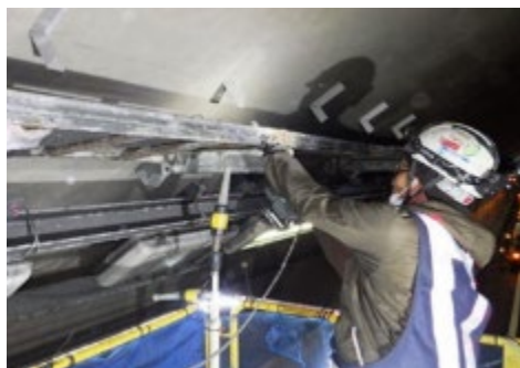
トンネル照明設備点検
