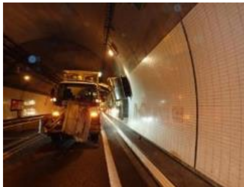
トンネルの側壁清掃
