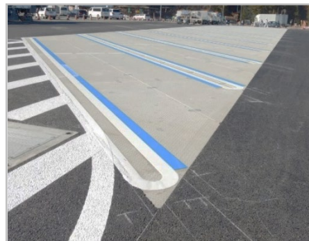
青色ラインによる「普通車・大型車兼用マス」の明示例
