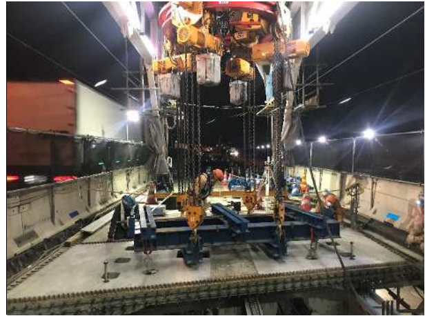
ハイウェイストライダーによる新しい床版の架設
