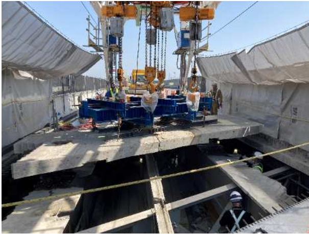
古いコンクリート床版の撤去
