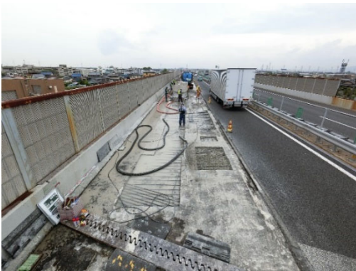
舗装・床版補修状況
