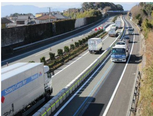
【コンクリート防護柵設置状況の例】
