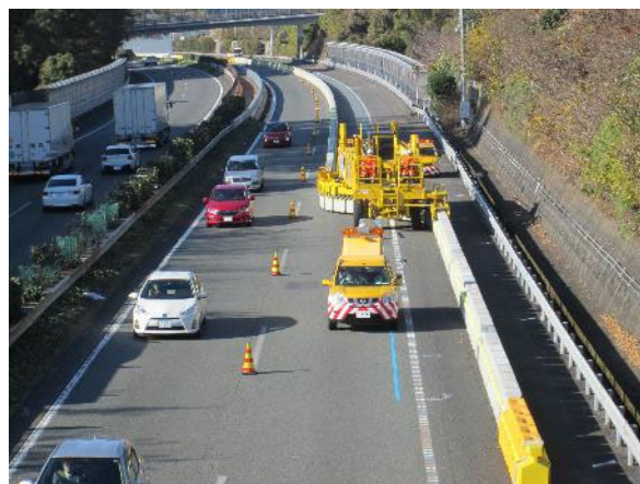
【コンクリート防護柵設置状況の例】
