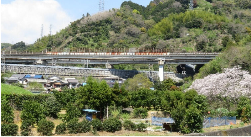
<清見寺橋 全景>
