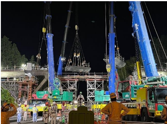
跨道橋撤去状況
