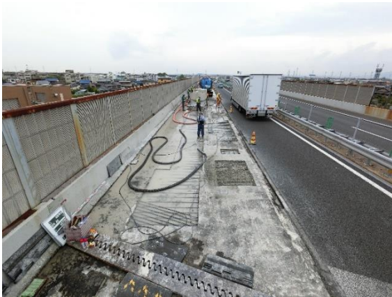
床版補修状況
