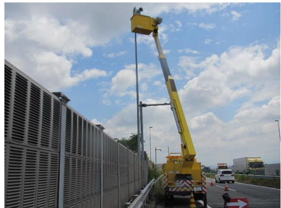
道路照明設備の点検
